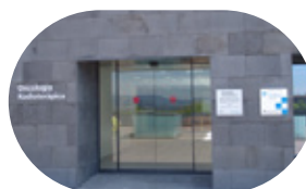
Unitat d'Oncologia Radioteràpica Manresa
