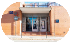
CAP Terrassa Nord Terrassa
